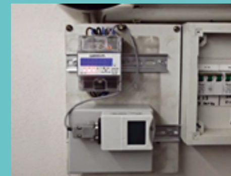
Logger S7021 odečítá a zaznamenává data z elktroměru
